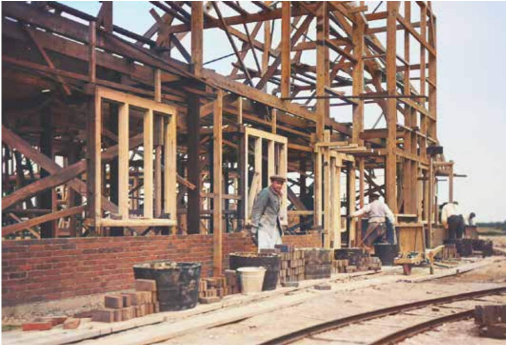
De bouw van Tuindorp Nieuwendam in 1925.
